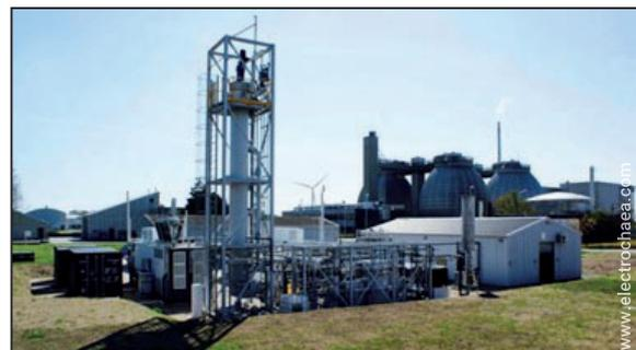
Figure 3. Site industriel avec colonne de biométhanation d'Electrochaea au Danemark
