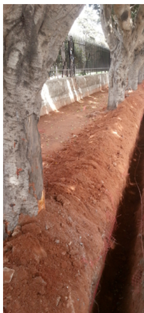
Figure 2. Travaux d'éclairage affectant le système racinaire des Ficus retusa de l'avenue la Victoire (janvier 2019)
